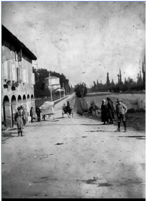
Figura 1: San Carlo via Chiesa vecchia nel 1919
