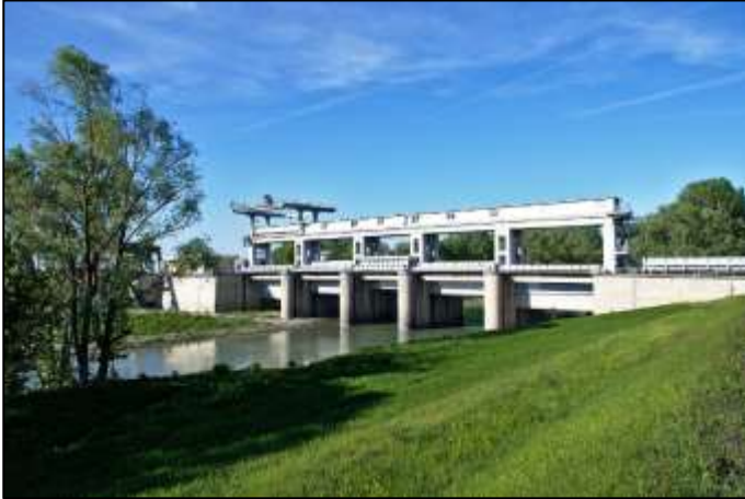
Figura 6: Chiuse del Reno e innesto Cavo Napoleonico
